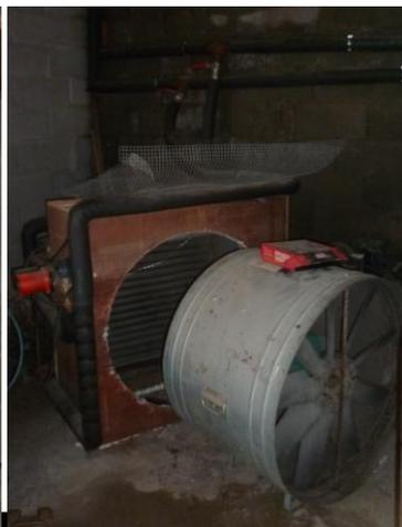
Echangeur avec ventilateur hélicoïdal
