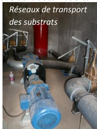
Le fonctionnement du système est de 8 000 heures par an, et durant cette période, l'agriculteur apporte 20 à 30 m<sup>3</sup> de substrat/jour dont 2/3 de lisiers et 1/3 d'autres déchets. L'acidité des substrats entrants doit être surveillée pour ne pas être bloquer la « digestion » du système.
