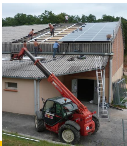
Dépose des plaques fibrociment amiantées et pose du PV
