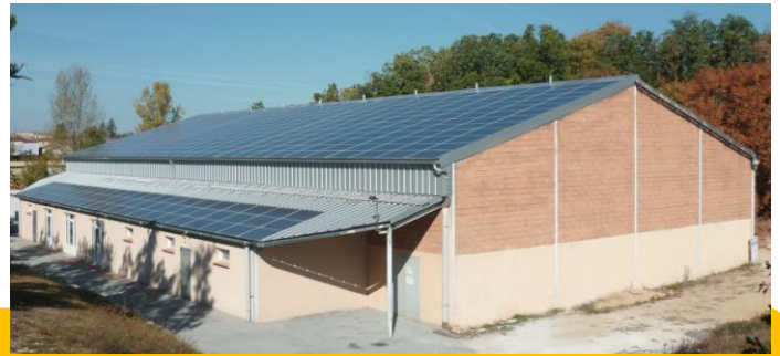
Vue de la halle des sports en septembre 2011
