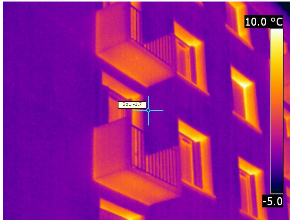
Ponts thermiques des dalles balcons
